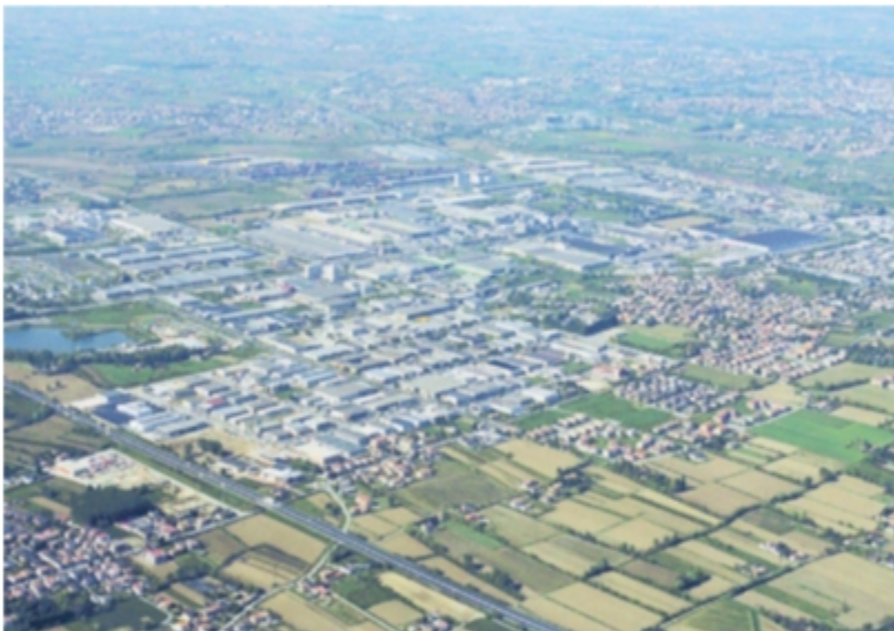
VEDUTA AEREA DELLA ZONA INDUSTRIALE DI PADOVA: ENTRO IL 30 NOVEMBRE IMPRESE E CITTADINI DEVONO PAGARE OLTRE UN MILIARDO DI IMPOSTE
