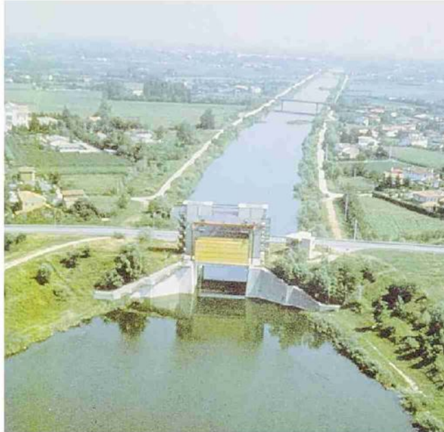
Un tratto già realizzato dell'idrovia Padova-Venezia
