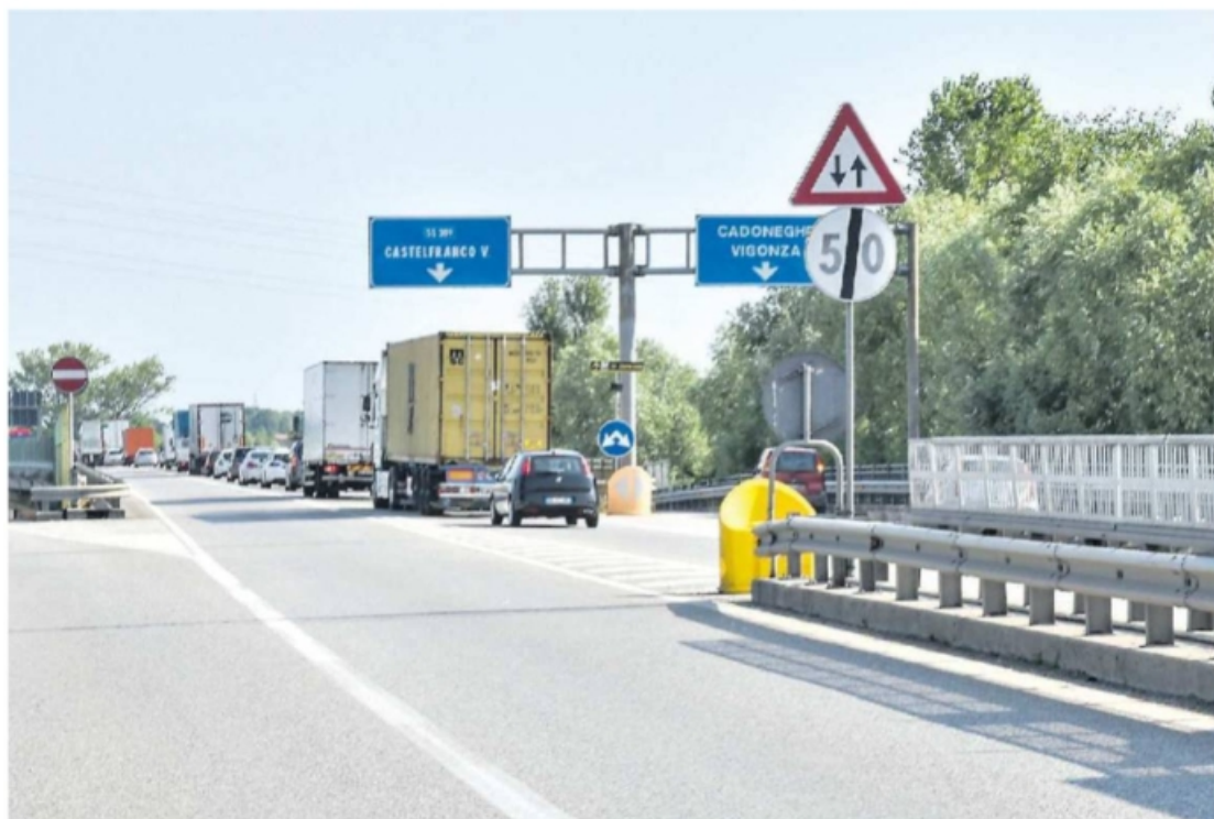
INTERVENTI URGENTI La strada regionale 308. Confapi chiede al neoeletto presidente della Provincia di accelerare sulle infrastrutture
